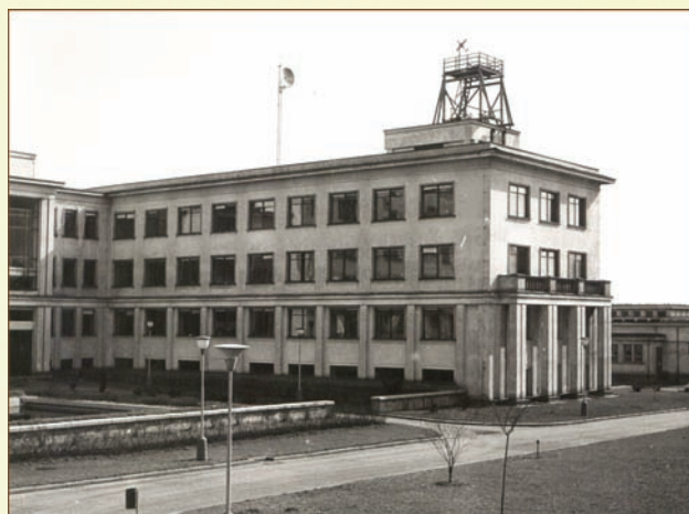
Obr. 6. Měřicí pracoviště na střeše budovy
